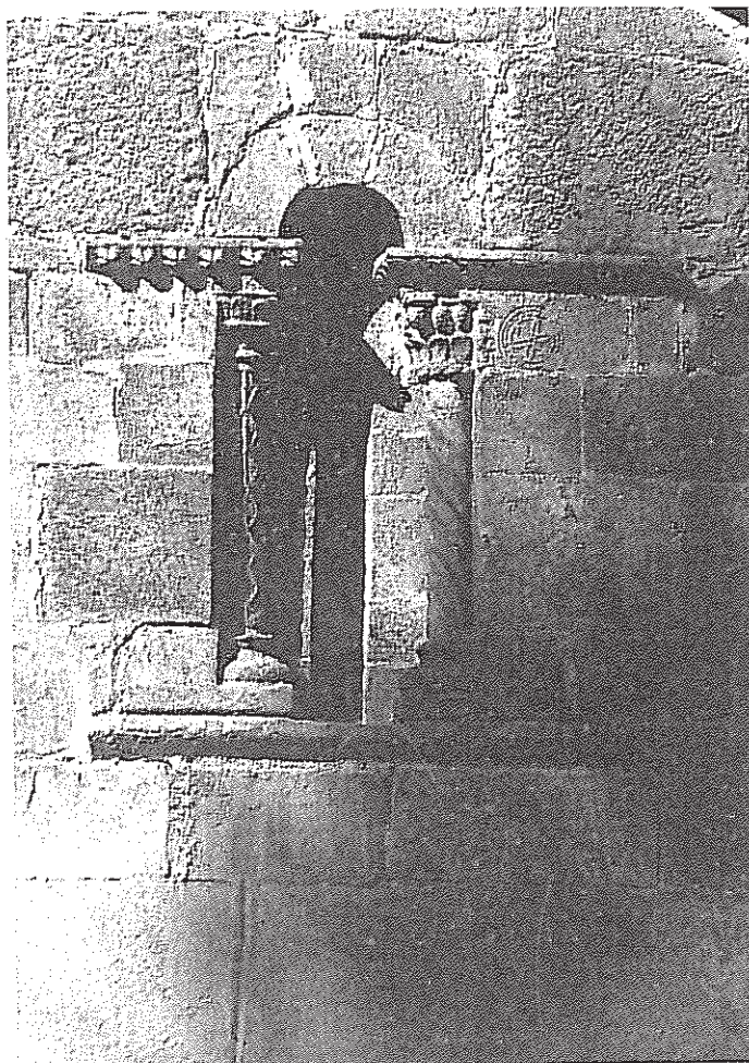
DETALLE VENTANA ÁBSIDE. FACHADA E.
